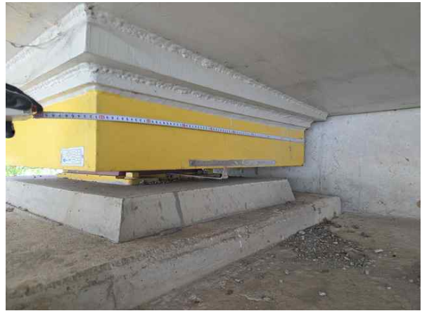
줄자를 이용한 부재치수 현장측정
